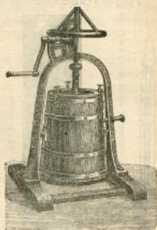
Сл. 3. Буњкалица с усправном осовином и с крилима — за ручну снагу.
