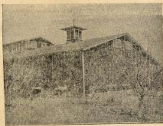
Сл. 4. — Зграда за чување већих количина јабука. При дну зидова су отвори за улаз свежег ваздуха, а кроз таван вентилатори за излаз унутрашњег ваздуха.
